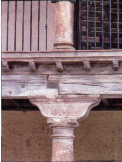
Figura 29. Detalle. Ensamblaje de vigas.
