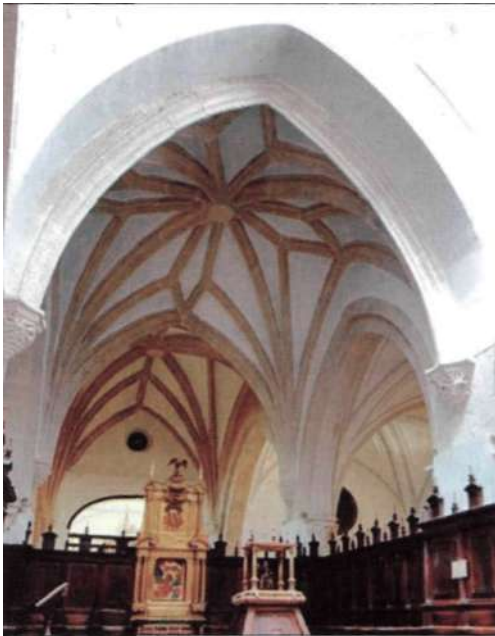
Figura 103. Bóveda de terceletes de la iglesia de Pastrana (Guadalajara).
