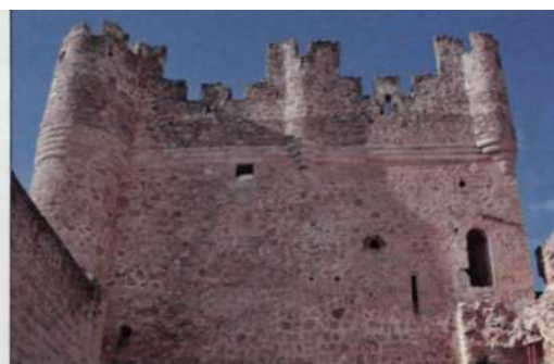
Figura 16. Muro de mampostería careada de la torre del homenaje del castillo de Berlanga de Duero (Soria).
