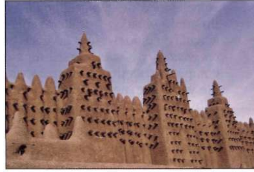
Figura 20. Mezquita construida en tapial de Djenne (Mali).
