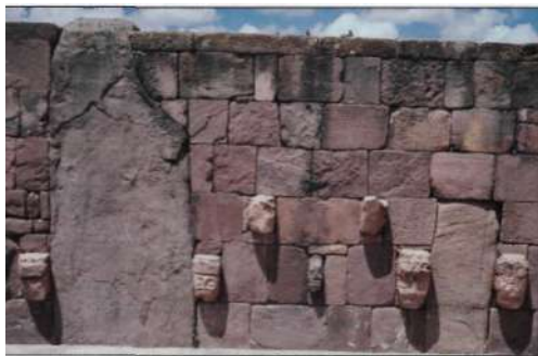
Figura 9. Piedras colocadas a hueso en Tiahuanaco (Bolivia).
