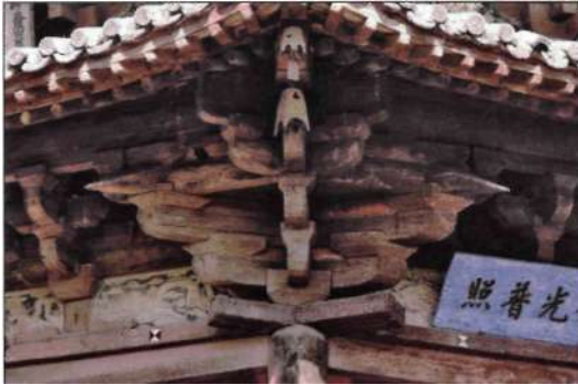
Figura 33. Detalle del ensamblaje chino conocido como dougong.
