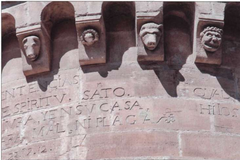
Figura 18. Muro de sillería con inscripciones y marcas de cantero.
