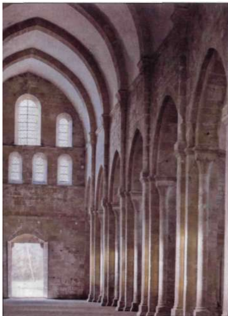
Figura 99. Bóveda de cañón apuntada románica, con arcos fajones. Monasterio cisterciense de Fontenay.
