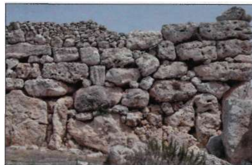
Figura 10. Grandes piedras colocadas a hueso en un poblado megalítico (Malta).
