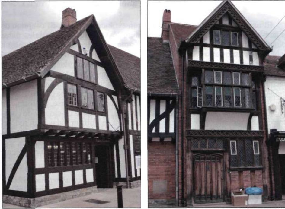
Figura 36. Típicas casas construidas con la técnica del entramado (Stratford, Inglaterra).
