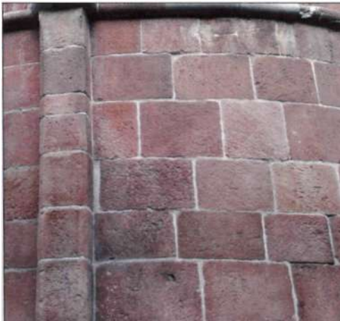
Figura 54. Sillería isódoma de piedra arenisca, en un ábside románico.
