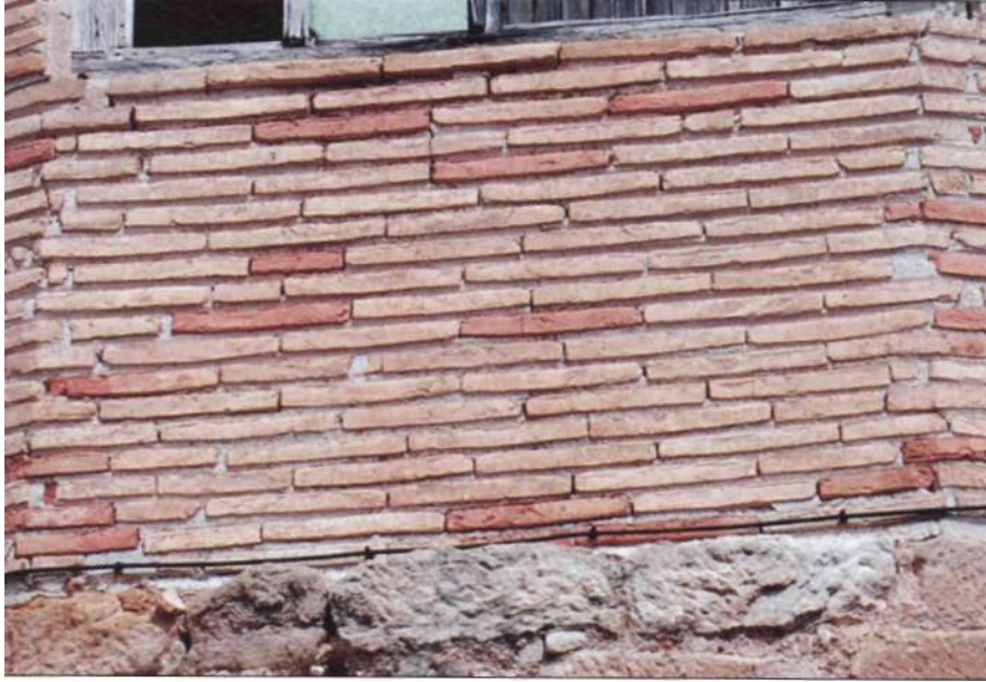
Figura 64. Aparejo de ladrillo a soga.
