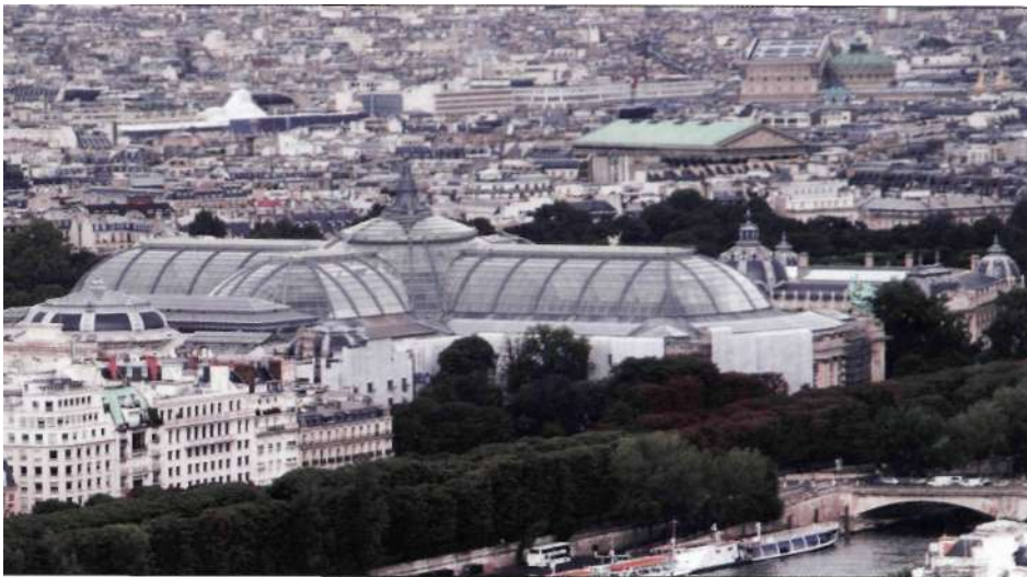
Figura 44. Cubierta exterior de hierro fundido y cristal del Hall Central de París (Francia).
