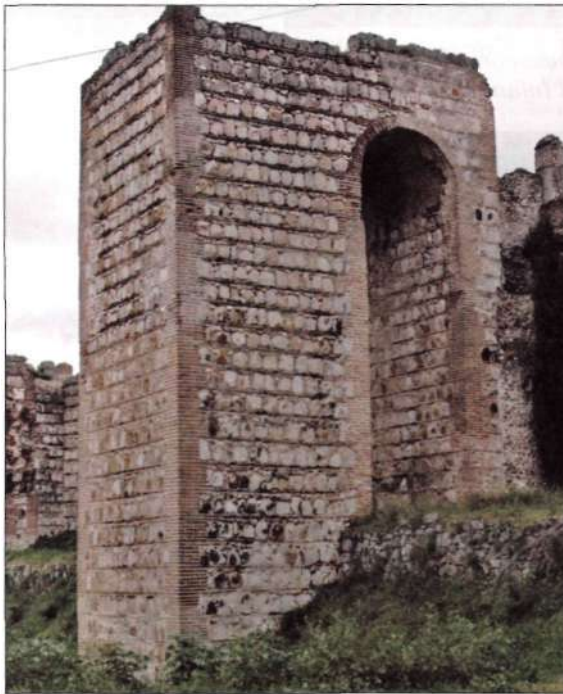
Figura 62. Sillarejo colocado a tizón. Castillo de Escalona.
