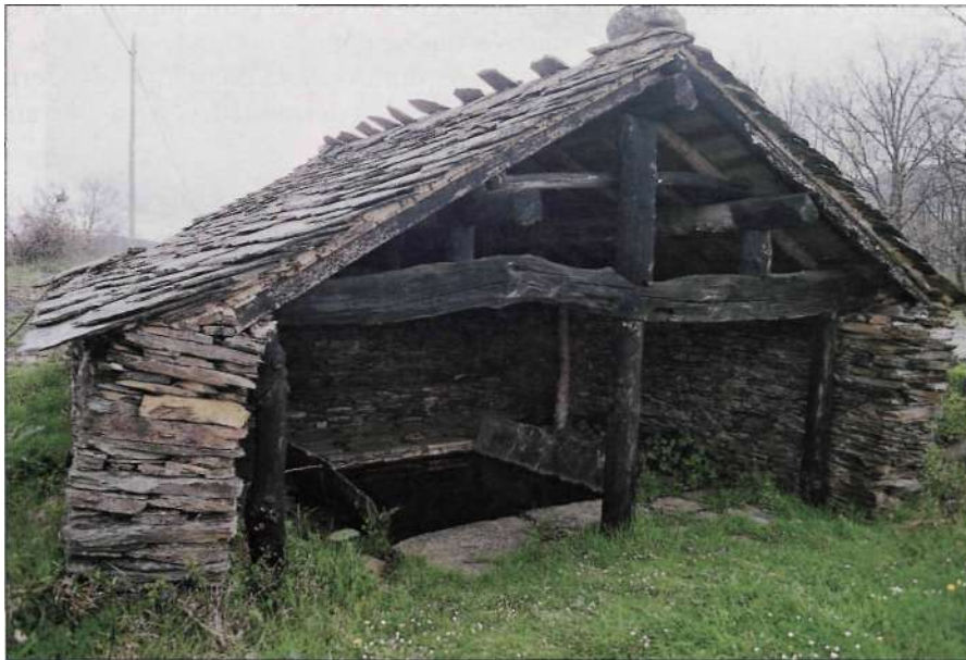
Figura 28. Armadura popular de doble pendolón (El Espinar, Guadalajara).
