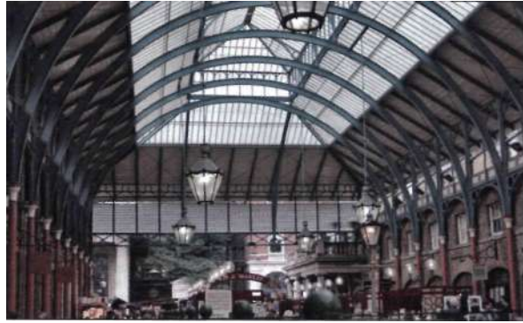
Figura 43. Estructura interior de hierro y cristal de la estación de Londres (Inglaterra).
