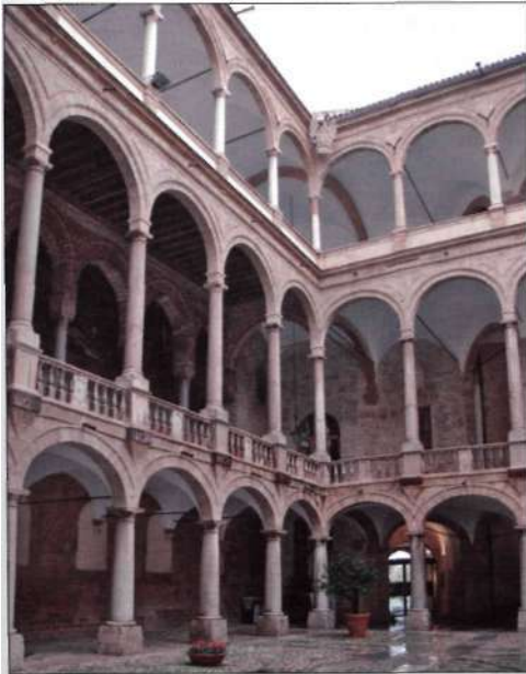
Figura 73. Patio de triple arquería. Inferior: arcos rebajados; media: arcos peraltados; superior: arcos de medio punto.
