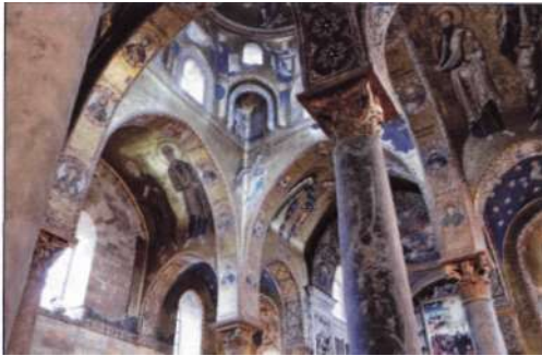
Figura 87. Arcos torales en el crucero de la iglesia de La Martorana de Palermo.
