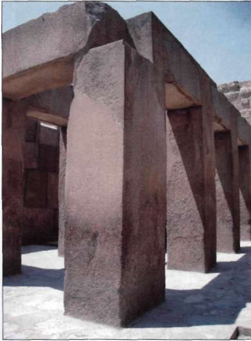
Figura 66. Sistema simple pilar-dintel. Templo del valle de la pirámide de Kefren.
