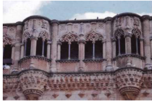
Figura 78. Galería de arcos conopiales decorados con tracerías góticas. Fachada del palacio del Infanzado (Guadalajara).
