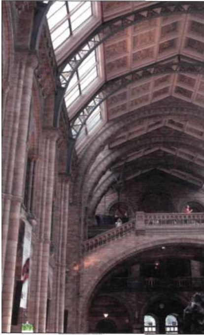
Figura 42. Estructura de cerchas de hierro fundido con construcción en piedra. Museo de Ciencias de Londres (Inglaterra).
