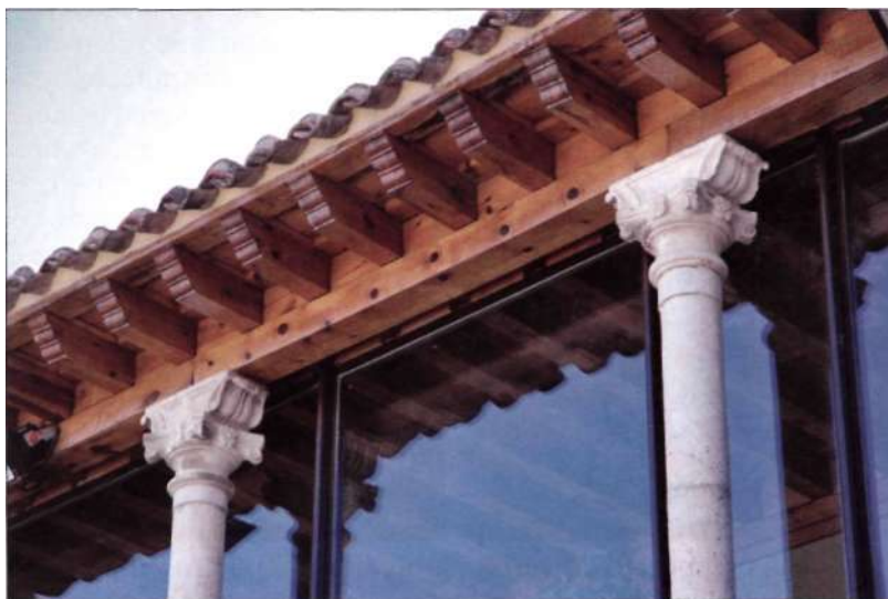
Figura 71. Columnas con zapatas de mármol sostienen un alero de madera.
