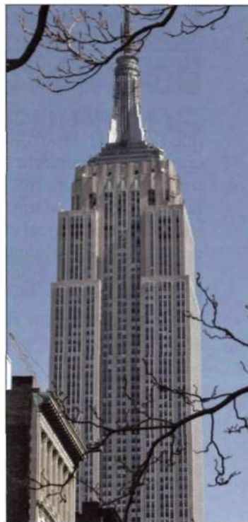
Figura 50. Empire State Building de Nueva York, en su construcción (1931) se utilizaron bloques prefabricados.
