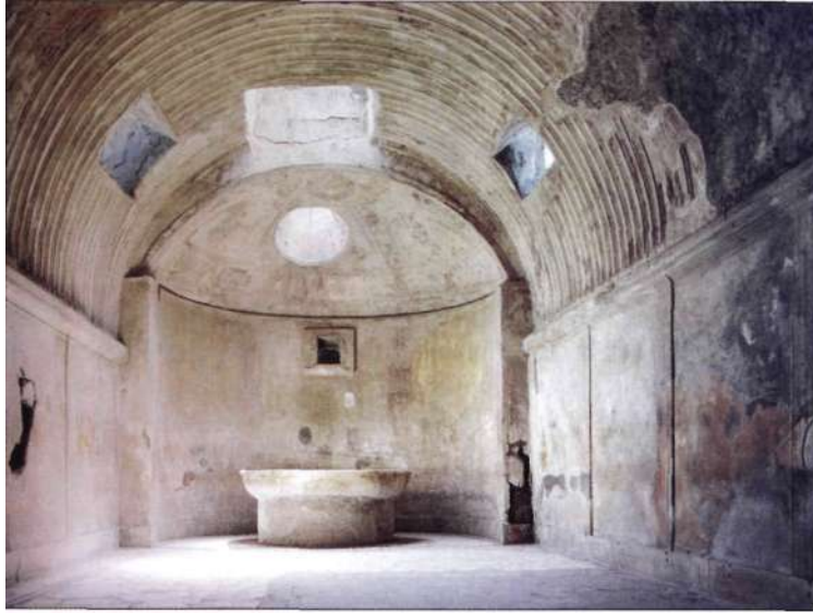
Figura 25. Bóveda de cañón del frigidarium de las termas de Pompeya, construida con opus caementicium.
