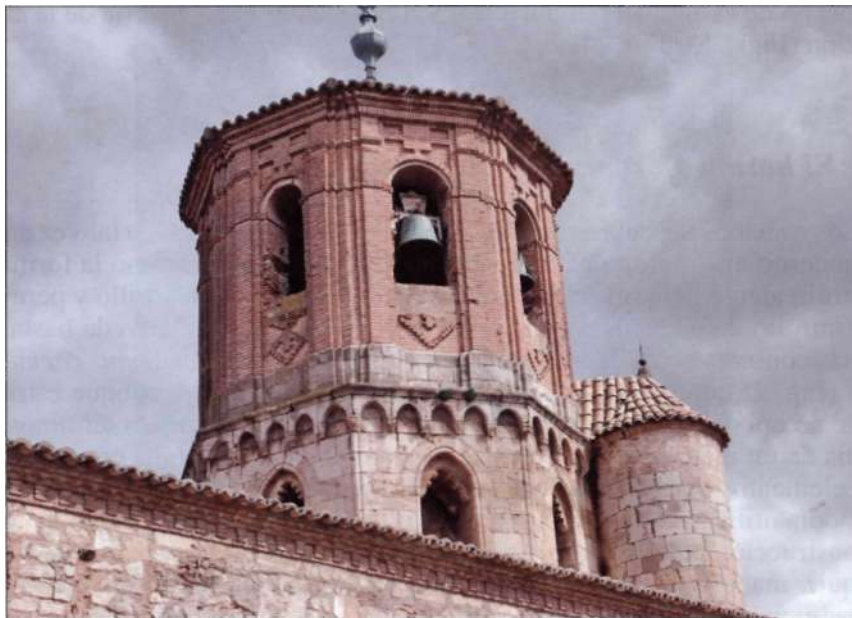
Figura 24. Torre campanario construida en ladrillo sobre una iglesia románica (Almazán, Soria).
