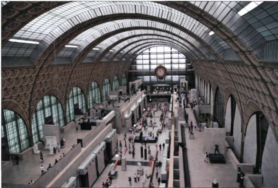
Figura 49. Cubierta de hierro y cristal del museo de Orsay, antigua estación de París (Francia).
