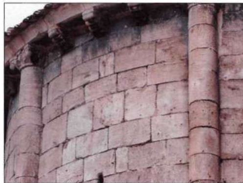
Figura 55. Sillería pseudoisódoma de piedra caliza, en un ábside románico.
