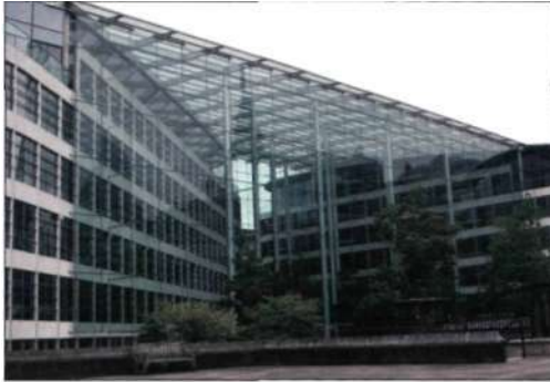
Figura 47. Muro de cristal, edificio de la City de Londres (Inglaterra).
