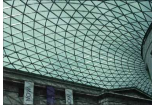
Figura 48. Cubierta de acero y cristal del Britis Museum de Londres (Inglaterra).
