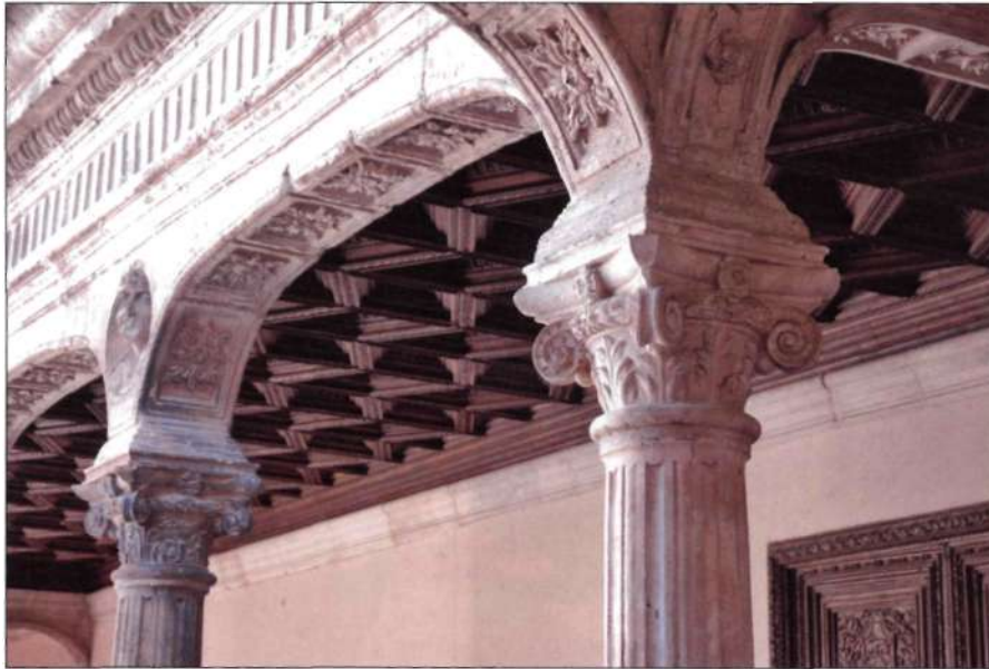
Figura 69. Capiteles clásicos del Renacimiento. El intradós del arco decorado con pequeños casetones y florón. Palacio de Peñaranda de Duero.
