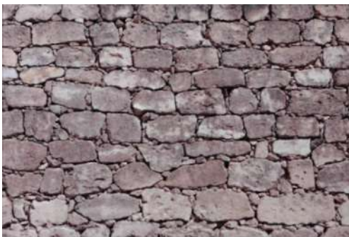
Figura 15. Sillarejo con ripio de piedra.
