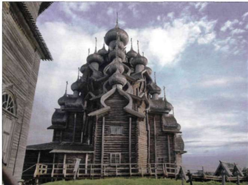
Figura 32. Iglesia construida enteramente en madera conocida como Pogost de Kizhi (Rusia).
