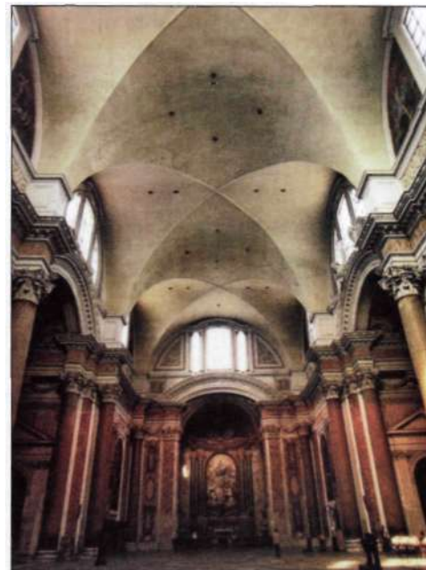
Figura 100. Bóvedas de arista de las termas de Diocleciano transformada en iglesia por Miguel Ángel.
