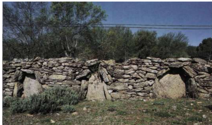
Figura 14. Muro de piedras naturales colocadas sin elaboración previa.
