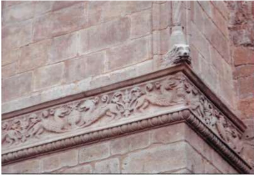
Figura 12. Conglomerante de barro en una construcción de perfecta sillería.
