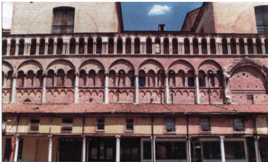
Figura 86. Arcos de descarga en el cuerpo intermedio de la fachada lateral de la catedral de Ferrara.
