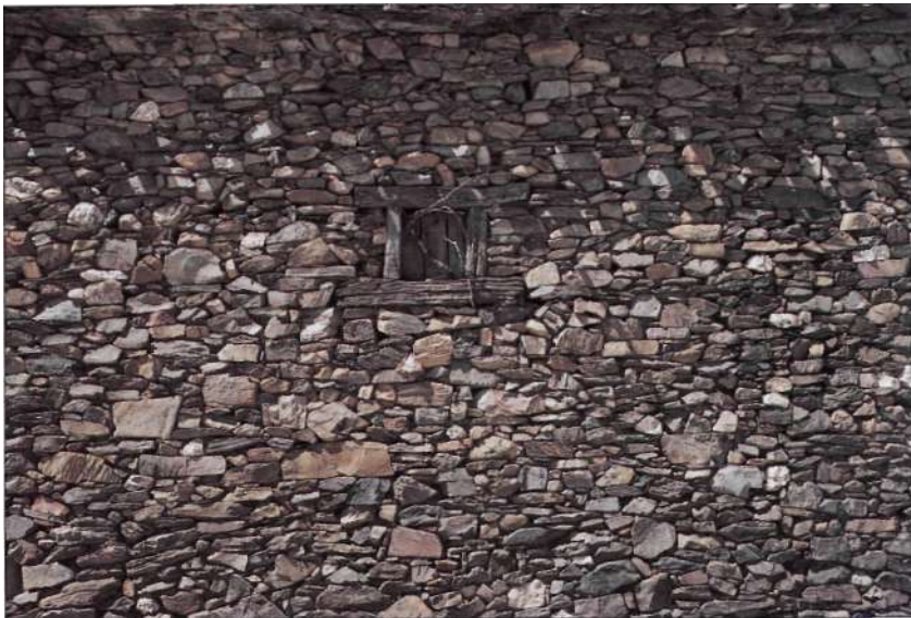
Figura 61. Manipostería irregular de pizarra.
