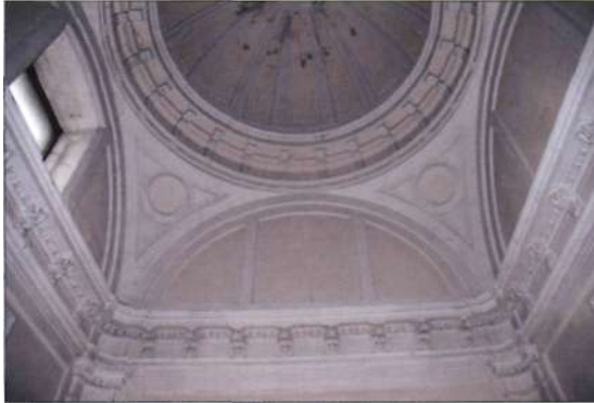
Figura 105. Cúpula encamionada sobre pechinas de la iglesia de Galapagos (Guadalajara).
