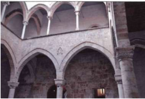
Figura 77. Patio con doble galería de arcos apuntados. Palermo Palazzo Speri (Palermo).
