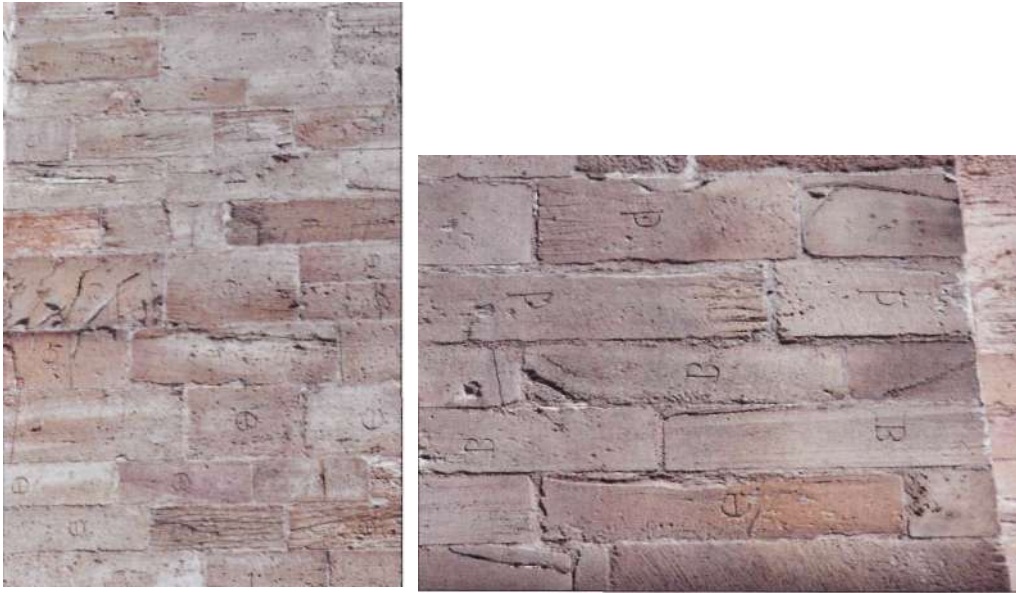
Figura 17. Muros de sillería con marcas de los canteros.
