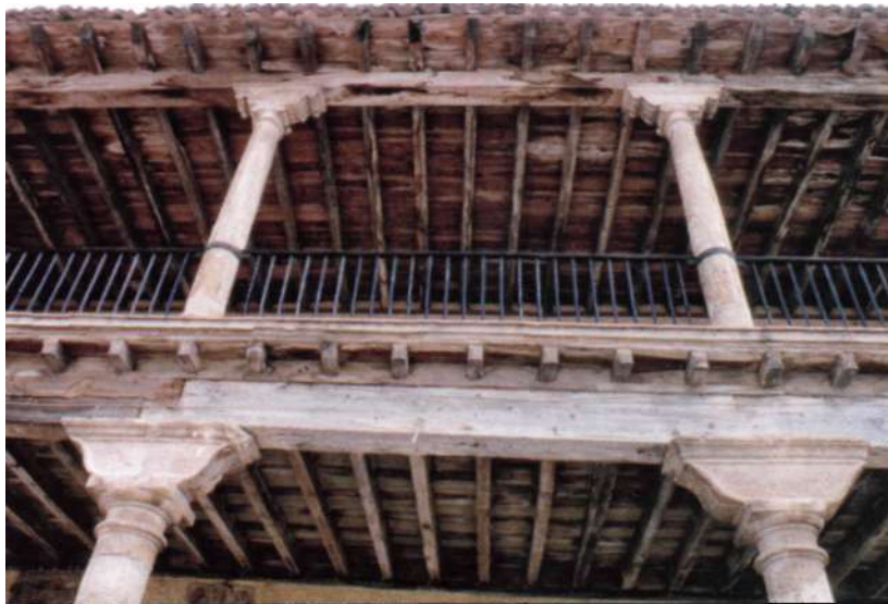
Figura 31. Simple estructuras de vigas de madera permiten la elevación de un segundo piso y la cubierta (Fuentelencina, Guadalajara).
