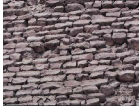
Figura 13. Conglomerante de limo en la pirámide escalonada de Zoser (Egipto).
