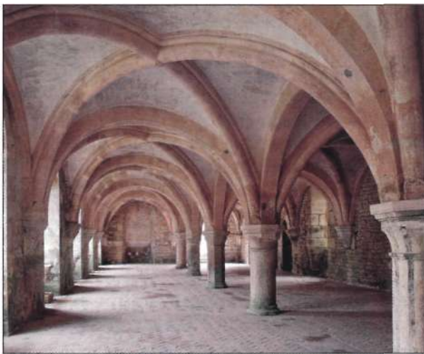
Figura 40. Cubierta de bóveda de arista de gruesos nervios del scriptorio del monasterio de Fontenay (Francia).
